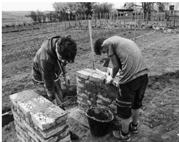
Noa und Andrin beim Brunnensbau.
