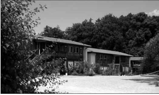
Schulhaus Bern, Melchenbühl
